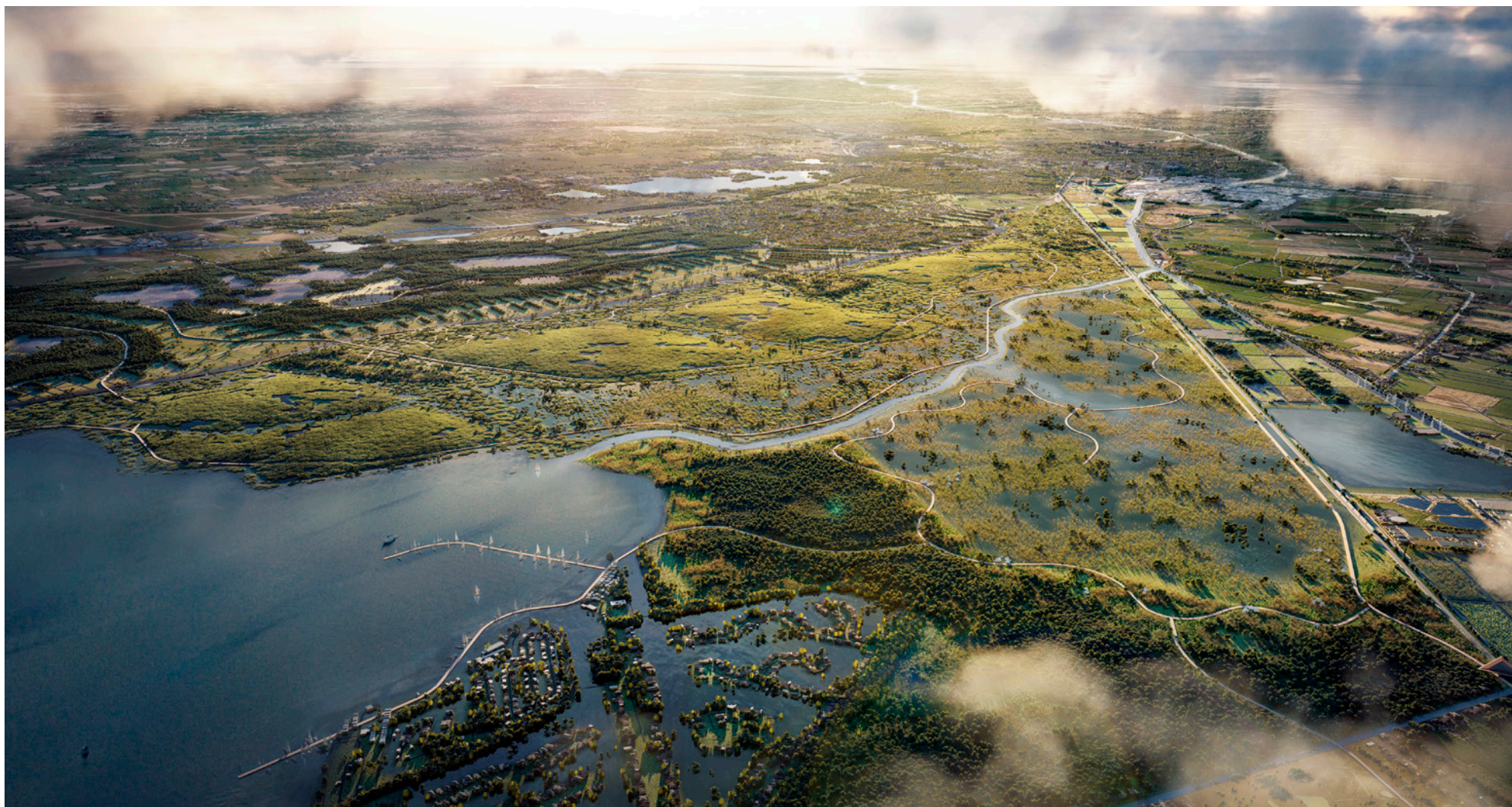
Waterbatterij. Links vooraan het Zuidlaardermeer. Bureau B+B
