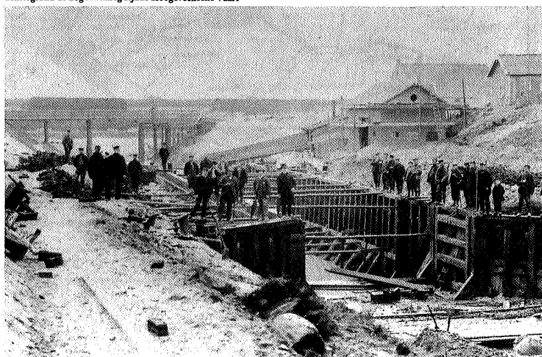
De Oranjesluis met het stoomgemaal in 1889 in aanbouw. Op de achtergrond de nog in aanleg zijnde Hoogeveense Vaart
