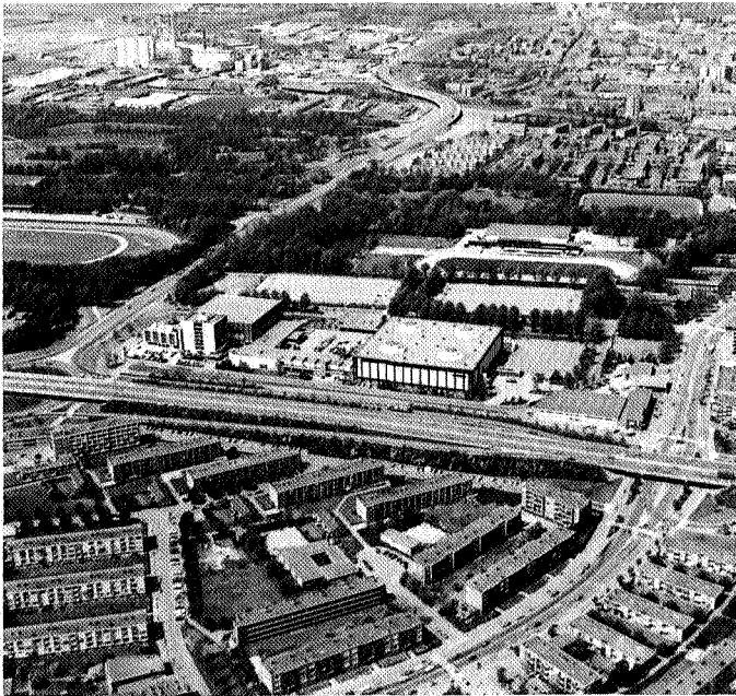
Van links naar rechts loopt de smelweg Drachten-Groningen vóór het Martinihalkomplex. Rechts de Paterswoldseweg. Het stadspark wordt doorsneden door de westelijke ringweg
