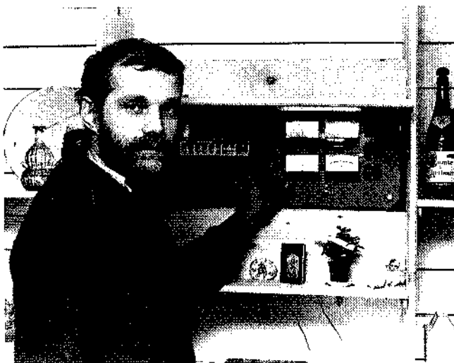
Willem Kuiper voor de regelkast waarmee de elektrische installaties aan boord in de gaten gehouden en ingesteld kunnen worden.
