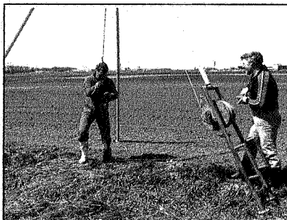
Medewerkers Grontmij plaatsen peilbuis
